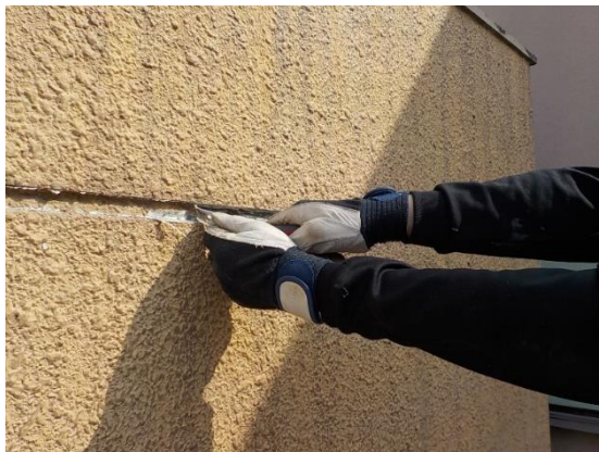
シーリング 撤去状況
