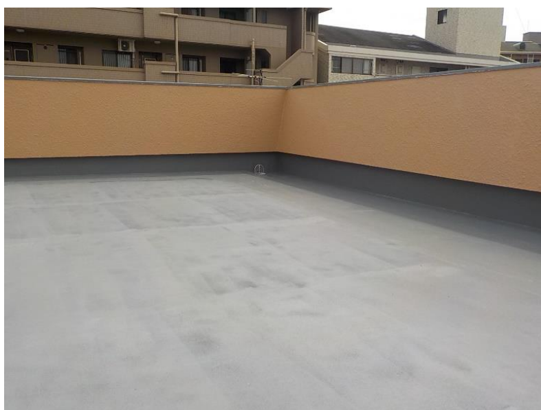
屋上塗装完了
