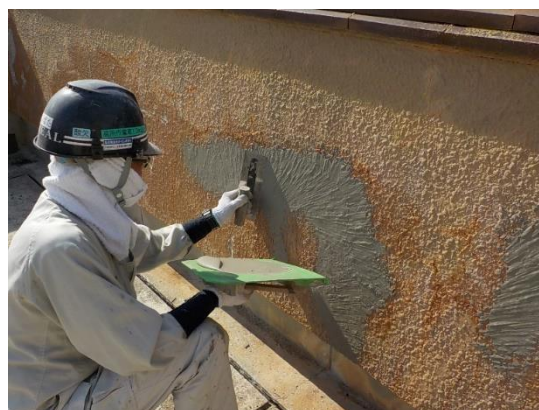
壁面下地補修状況
