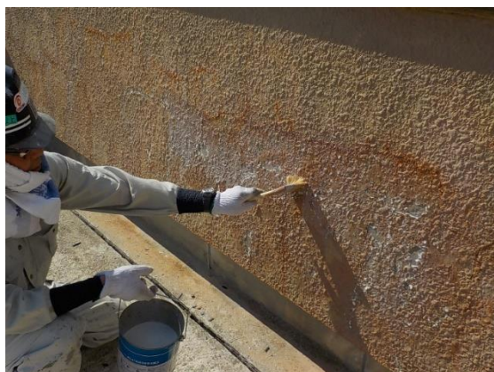
壁ﾌﾟﾗｲﾏｰ塗布状況
