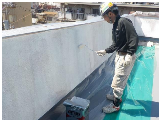
防水弾性塗装塗布状況
